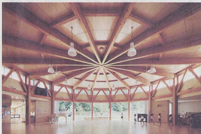
100年たっても住み続けられる住まいだった。同社が飛躍するきっかけとなったのは、95年の阪神大震災。神戸市灘区で多くの家屋が倒壊する中、KES構法で建てた木造住宅がぼつんと立っている姿は、関係者の注目を集めた。KES構法に代表される接合金物工法はその後、木造建築の主流になっていく。それだけの衝撃を建築界に与えた。
